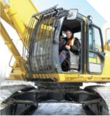
Florent Bouchard sur le chantier d'Eastmain-1.
